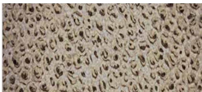
Problème avec le catalyseur - Des cendres et de la suie s'accumulent à la surface du catalyseur en cours de fonctionnement normal. Des cendres s'accumulent du fait de la combustion de la fumée dans le catalyseur et de l'extraction de la boîte à feu par le tirage de la cheminée.
